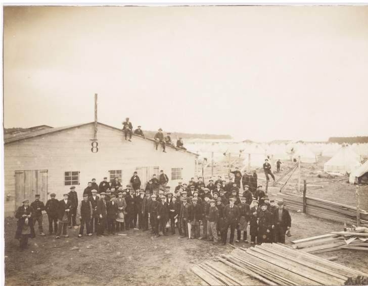
De bouw van de nieuwe barakken met hulp van de geïnterneerden.
